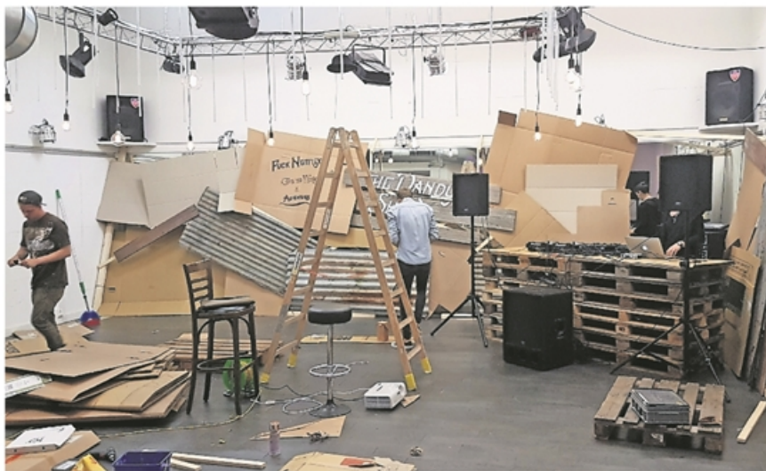
Die Aufbauarbeiten für die «Dandy Shacks»-Beiz laufen auf Hochtouren.
