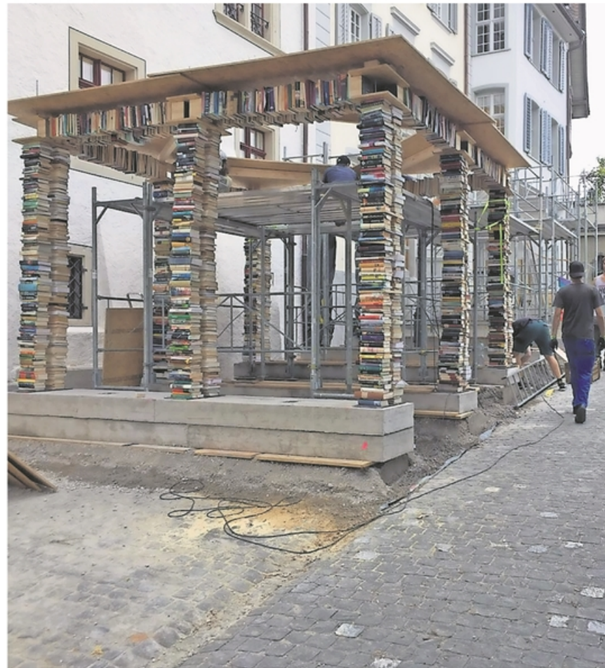
Die Aufbauarbeiten für die «Usvers»-Beiz sind in vollem Gange.
